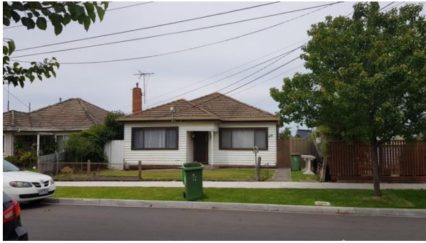
Figure 12 15 Fontein Street (subject site)
